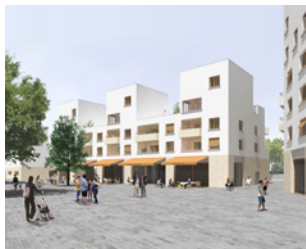
Villenave d'Ornon Aristide-Briand 19 a
